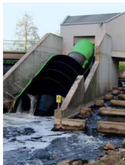
Starker Sandeintrag durch Erosion in die Bocholter Aa (links) und Wasserkraftwerk mit Organismenaufstieg. Fotos: Michael Kempkes
