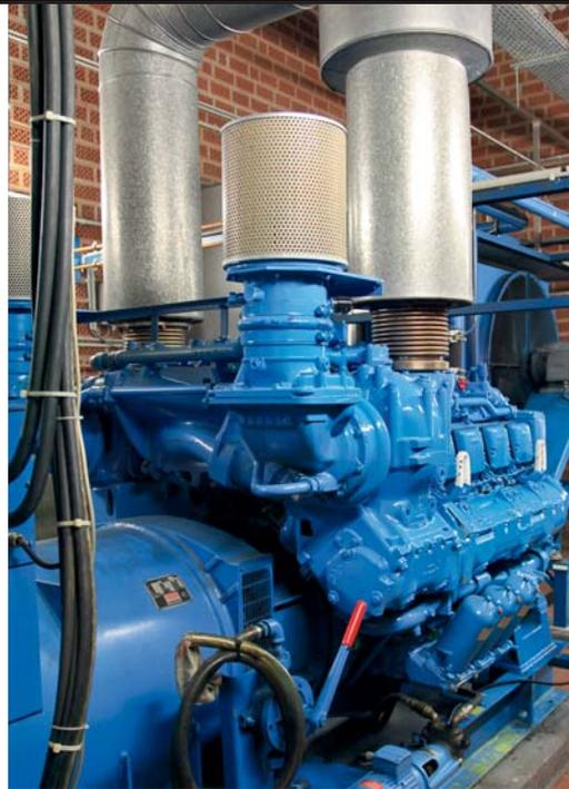
Notstromaggregat 1000 kva
