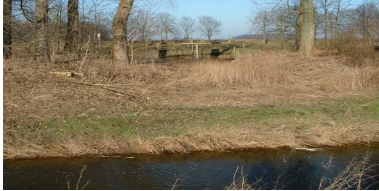
Entlastungsbauwerk Vorne Emmerbach Im Hintergrund Dortmund-Ems-Kanal Foto vom 07.02.2005
