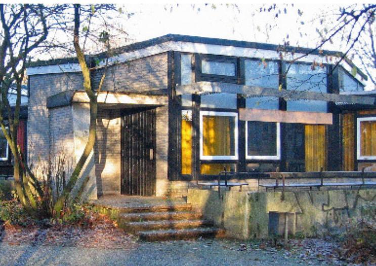
11 Schäden an Fenstern, am Sonnenschutz und am Dach. 2004.
