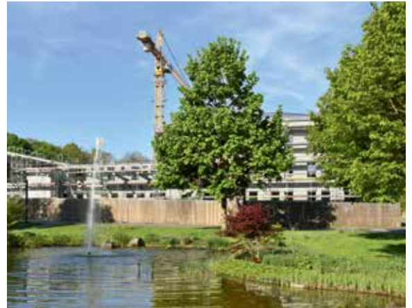
Klinikneubau Baustelle Juni 2017
