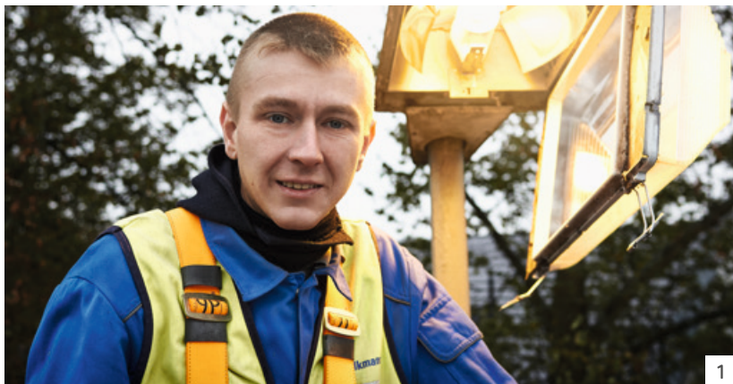
1 Höhenfest: Die Reparatur und Wartung der Straßenbeleuchtung erfolgt in 10 bis 12 Metern Höhe. Foto: Moritz Ortjohann
