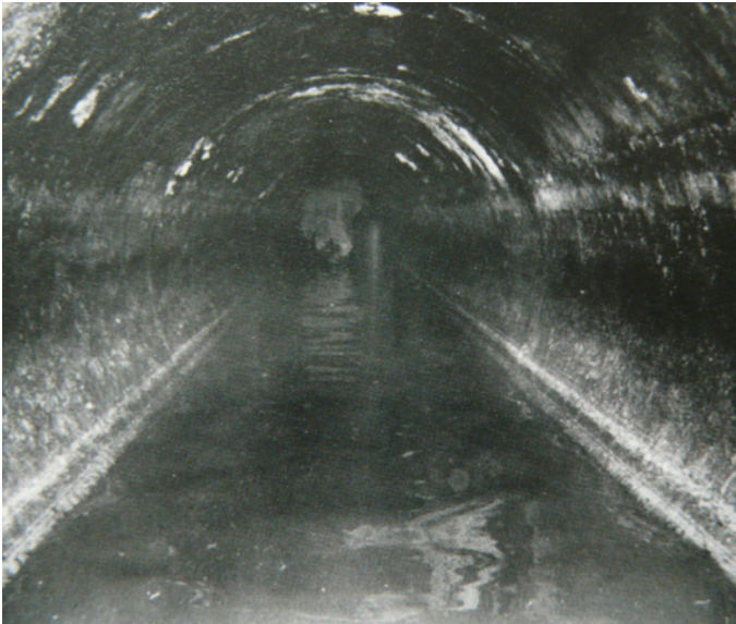
Bild: Tiefbauamt Dortmund
