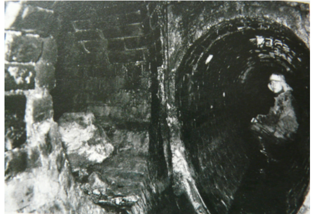
Bild: Tiefbauamt Dortmund
