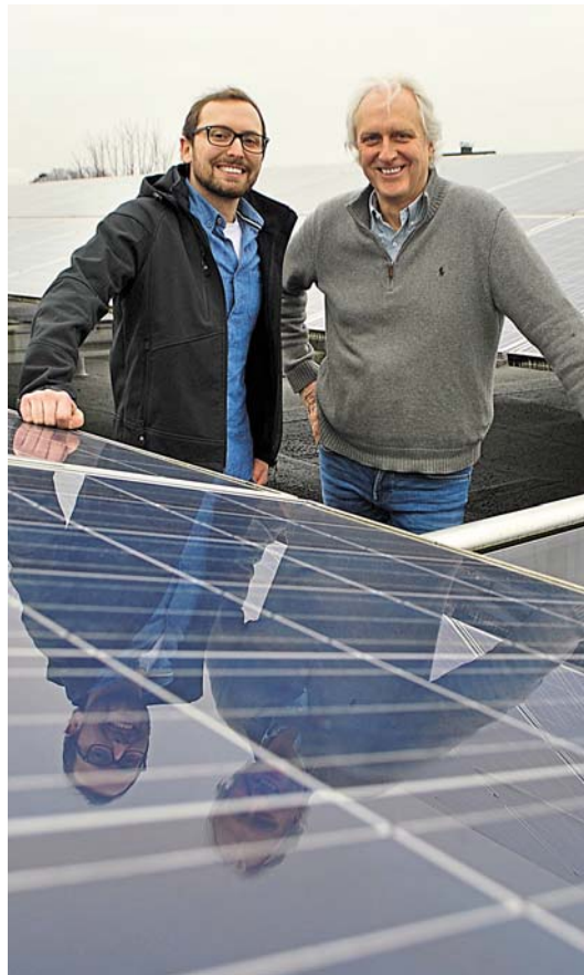
Dank Ausrichtung nach Ost und West liefert die Photovoltaikanlage von Tim (l.) und Andreas Stegerhoff bei Sonnenschein ganztägig Strom. Foto: Hertel/IHK
