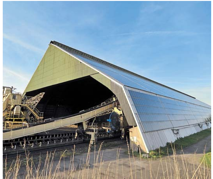
Die ehemalige Kohlemischhalle, bestückt mit Solarmodulen, bleibt stehen.
