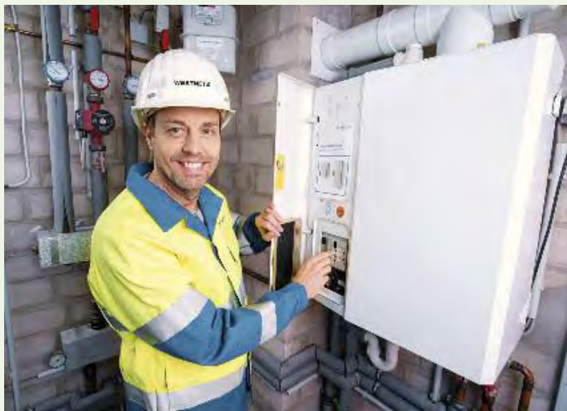
Ab November 2017 bekommen Haushalte und Gewerbebetriebe in Werther Besuch von Westnetz, damit alle Gasgeräte erfasst werden. Foto: Westnetz GmbH
