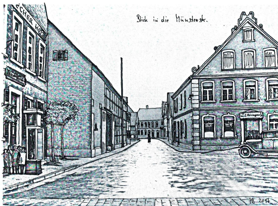
Nr.18 Blick in die Münsterstraße vom Marktplatz aus (histor. Situation vor 1945)
