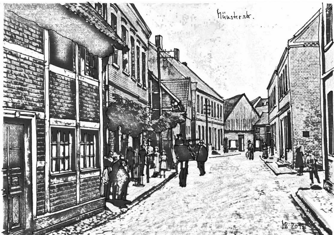
Münsterstraße: Blick stadteinwärts (historische Situation)
