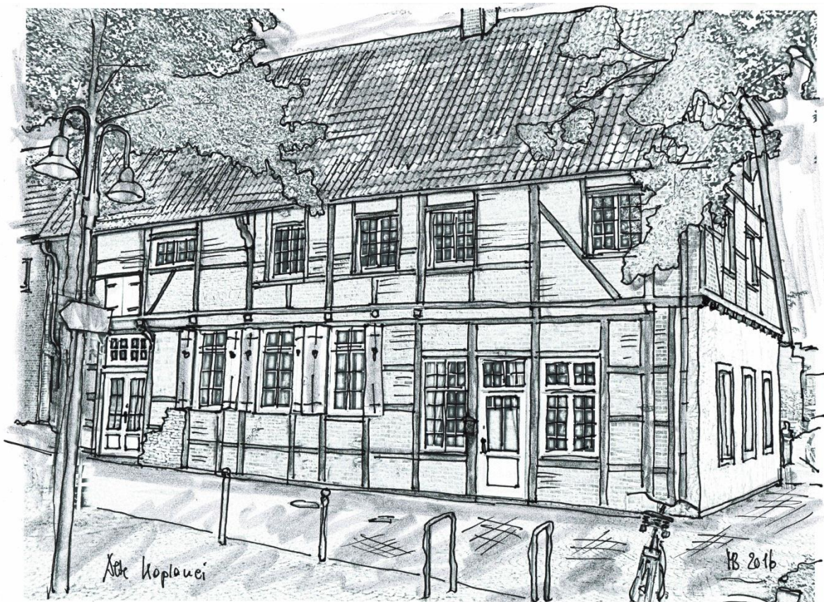
Nr.17 Kirchplatz 12 ehem. Kaplanei
