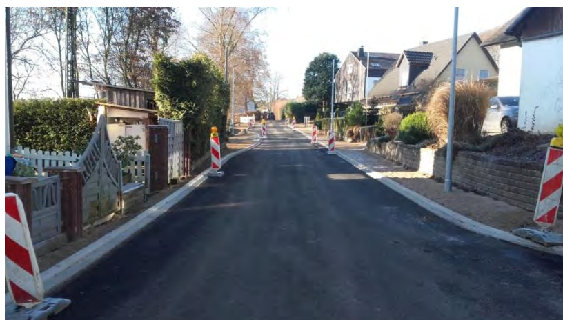
... die Asphalttragschicht ist eingebaut ...
