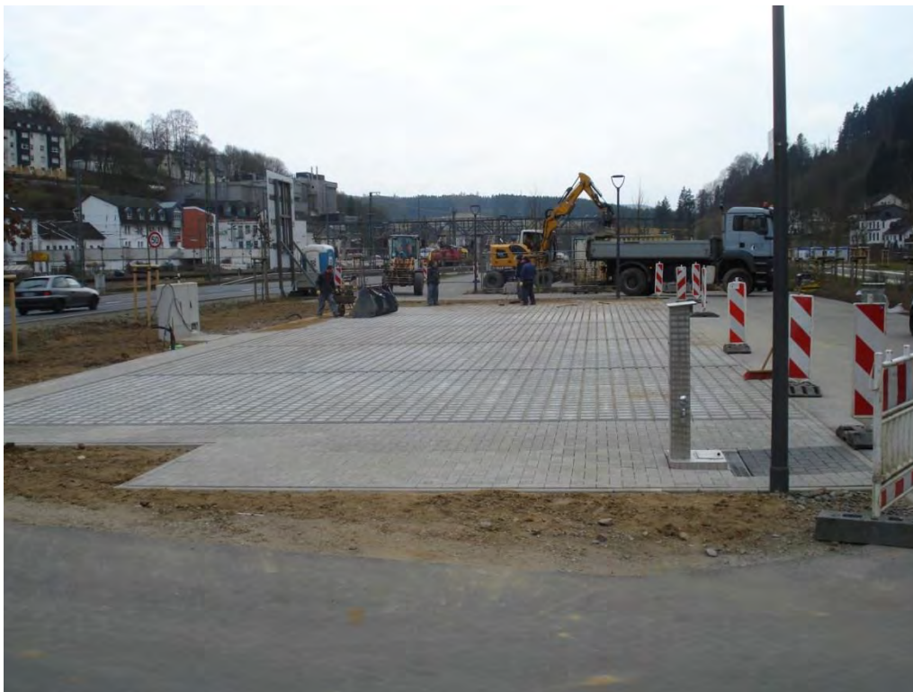
Pflasterarbeiten am Wohnmobilstellplatz
