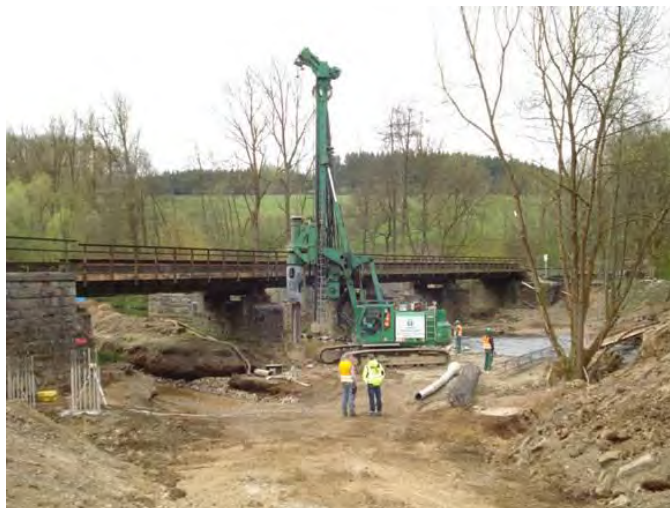
Bohrgerät im Einsatz
