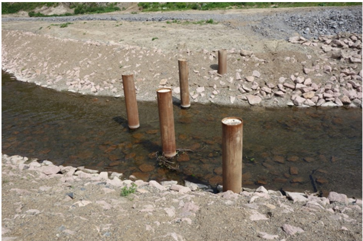
Abb. 1: V-Rechen als Treibgutfang (Quelle: Eiden, 2016)
