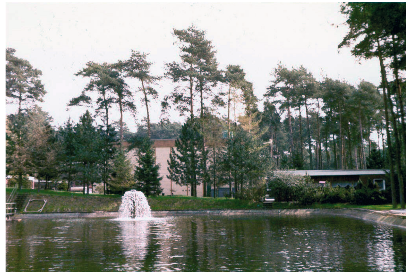
Das Wasserwerk Nordrheda-Ems 1980. Vorn ein Versickerungsteich zur Grundwasseranreicherung mit Wasser aus der Wapel.
