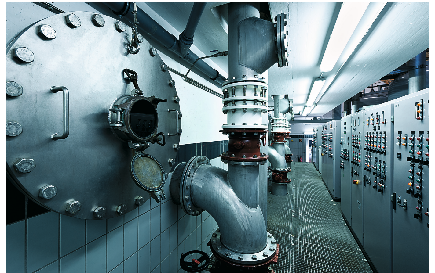
Innenansicht des Neubaus in Quenhorn
