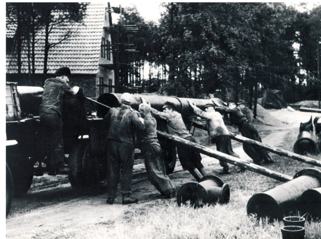
Arbeiten im Gewinnungsgebiet Spexard im Zuge der Verlegung einer Rohwassertransportleitung aus Grauguss 1947/48
