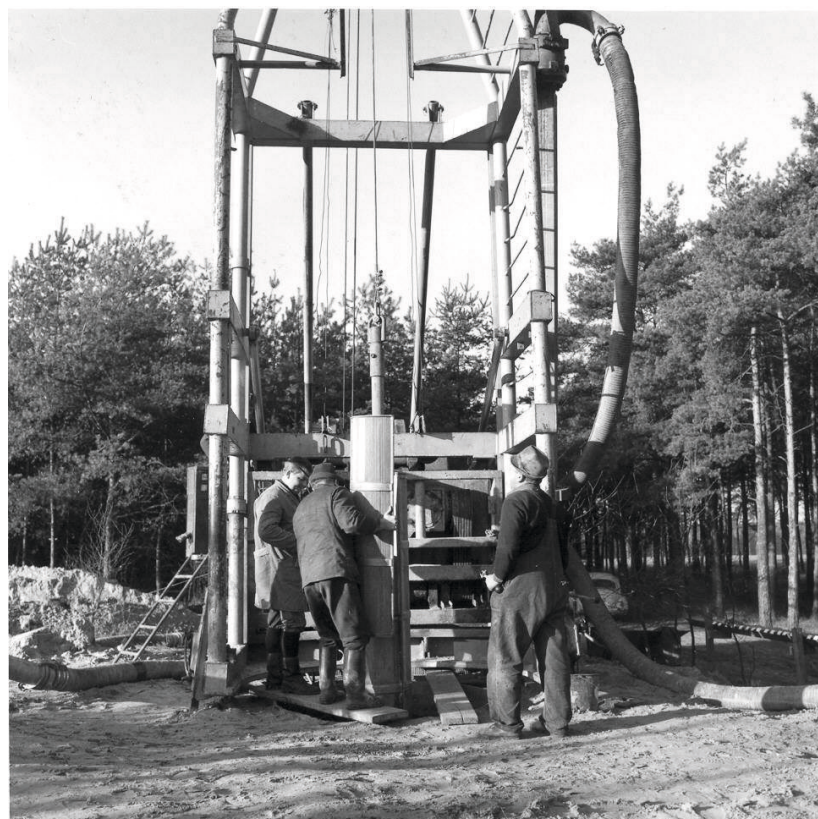
Bau der Brunnen 25 – 29 im Gewinnungsgelände Rhedaer Forst, 1972
