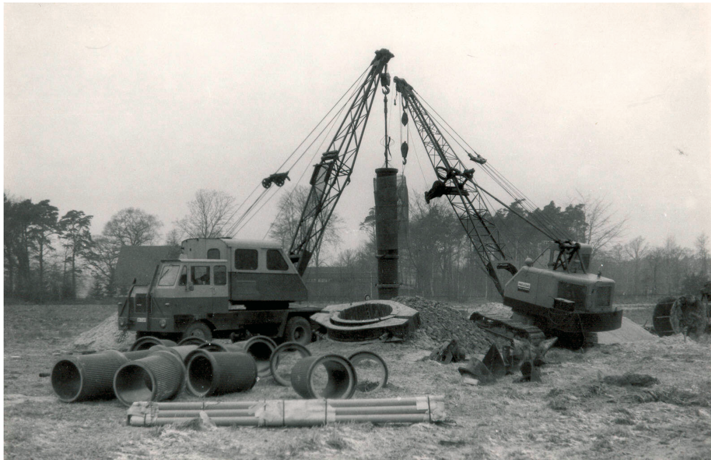
Bau des Vertikalbrunnen 1 in Quenhorn 1969
