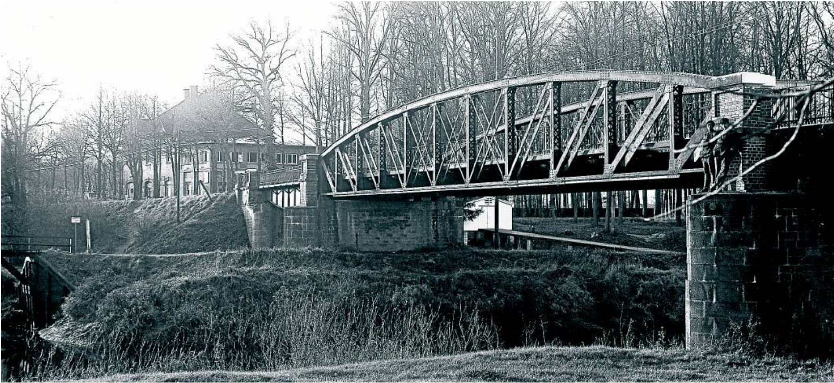
Die Emsbrücke bei Bisping-Waldesruh wurde im Juli 1907 in Betrieb genommen.
