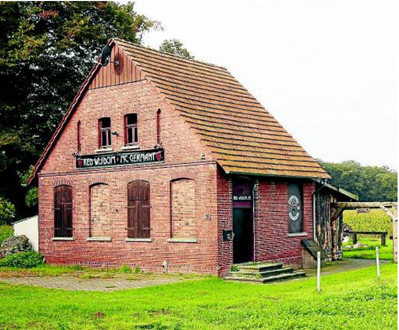
Als Clubheim nutzte zuletzt der Motorrad-Club „Red Wisdom“ das ehemalige Schulgebäude. Fotos: Dieter Schmitz (2), Jens Keblat
