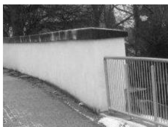
Stützmauer, Vorher – Nachher
