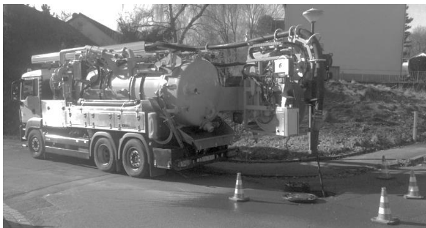
Kanalspülfahrzeug der TBS
