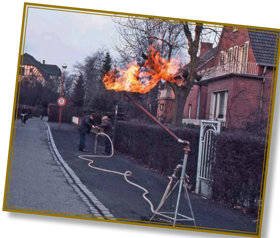
Bevor das Erdgas durch die Leitungen strömte, wird wie hier im Südwahl das alte Stadtgas abgefackelt.
