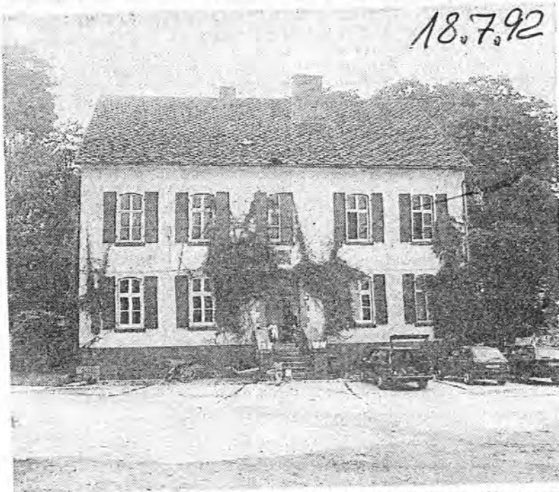
Unter Denkmalschutz gestellt: das Herrenhaus auf Gut Wulfstal bei Upsprunge. Foto: Ferdi Michels
