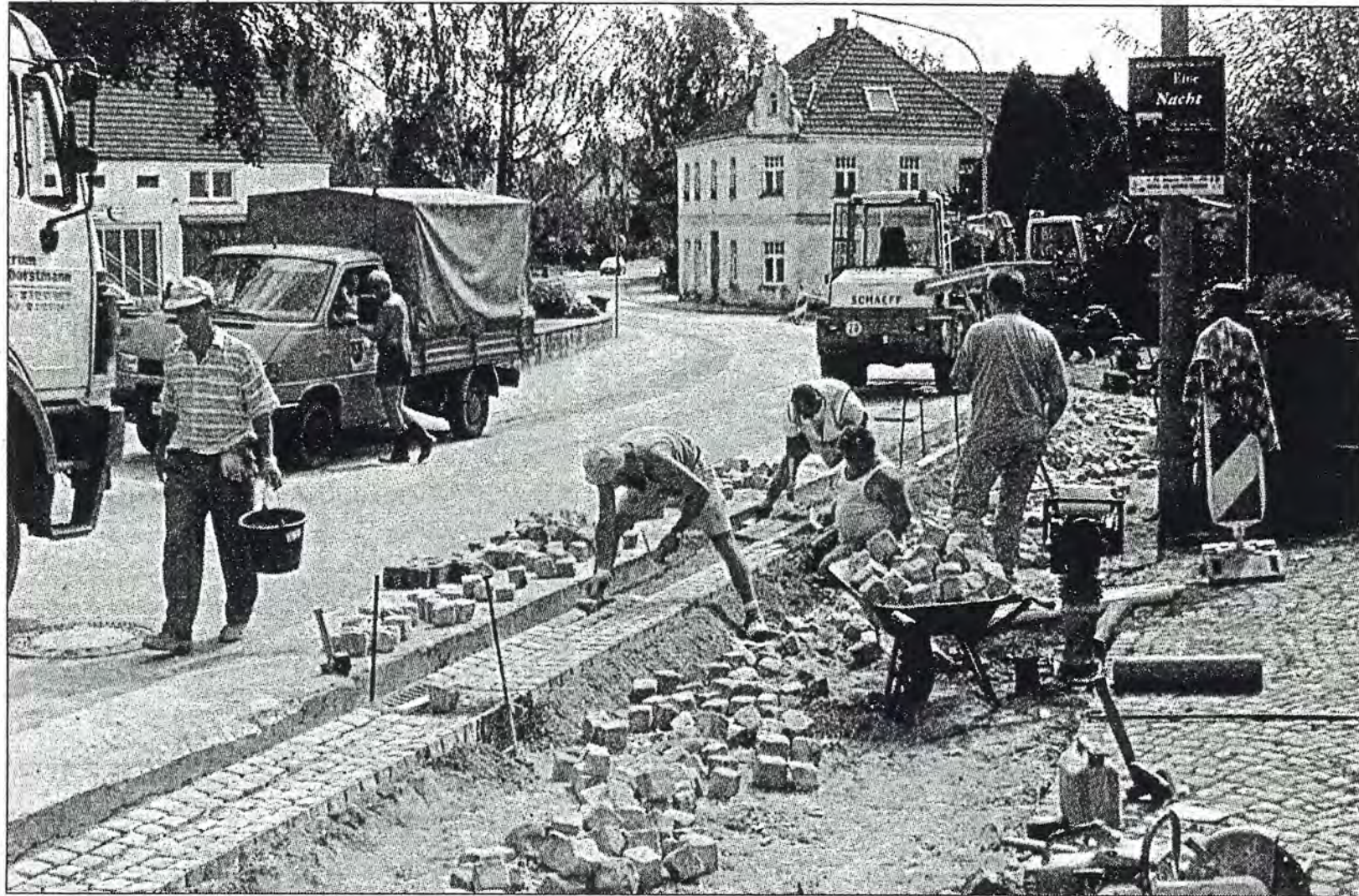
Die Bauarbeiten in der Hederbornstraße kommen zügig voran. Mitarbeiter der Firma Montag sind dabei, Pflaster und Rinnen zu verlegen. Die Dorferneuerungsmaßnahme wird mit einem Landeszuschuss in Höhe von 50 Prozent gefördert. Foto: Jürgen Spies
