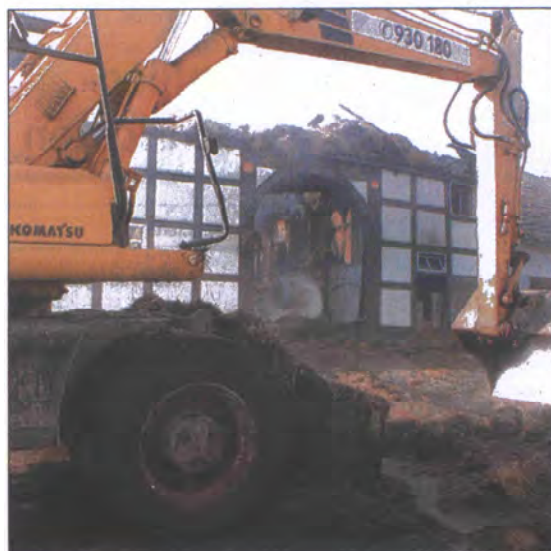
Ein Bagger rückte gestern an, um den abgebrannten Hecker-Hof aus 1791 in Upsprunge abzureißen. Das alte Haus war nicht mehr zu retten.
