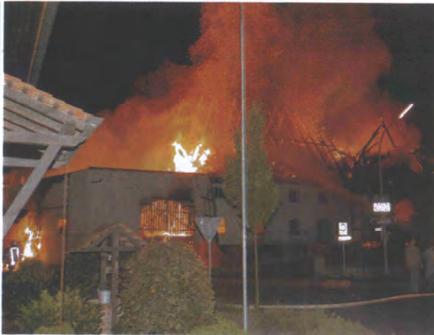
Das Stallgebäude des Hofes Hecker brannte lichterloh: Schnell war ein Teil des Dachstuhls zusammengebrochen.
