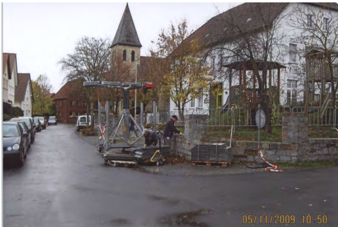
Bei den Bauarbeiten
