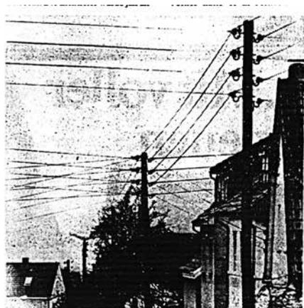
1910 wurde der Strom einfach durch auf der Straße verlegte Kabel an die Haushalte herangeführt. Freilandleitungen - wie hier in Lendringsen - gibt es heute nur noch in Außenbezirken Mendens. In der Innenstadt sind die Aluminiumleitungen unterirdisch verlegt.
