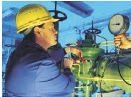
Installationen zur Druckerhöhung in den Netzabschnitten mit Niederdruck, so dass die geodätischen Höhenunterschiede Mendens zu vernachlässigen sind und alle Abnehmer am tiefsten und höchsten Punkt des Versorgungsnetzes konstant mit dem erforderlichen Gasdruck beliefert werden.
