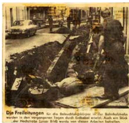
**Die Freileitungen** für die Beleuchtungskörper in der Bahnhofstraße wurden in den vergangenen Tagen durch Erdkabel ersetzt. Auch ein Stück über Hochstraße (unter Bild) werde von diesen Arbeiten betroffen.
