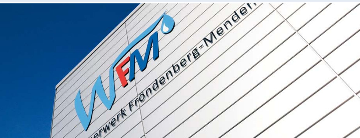
Das Wasserwerk Fröndenberg-Menden an der Ruhr sichert die eigenständige, kommunale Wassergewinnung und -verteilung.
