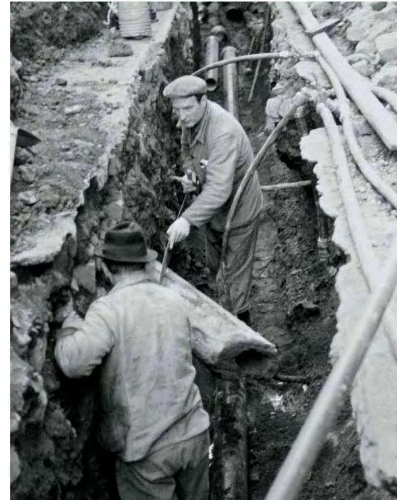
Bei der Neuverlegung von Gas- und Wasserleitungen stoßen Mitarbeiter der Stadtwerke Iserlohn 1968 in der Laarstraße auf alte Holzwasserleitungen. Im Bild die Rohrleger Gerd Hinz und Karl Schmidt.
