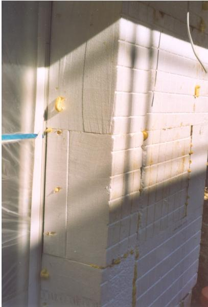
Abb. 6 Große Dämmstoffpakete in die Sanierung der Fassaden integriert und optimal ausgeführt sind wirtschaftlich und spart den Löwenanteil Energie in einem Altbau
