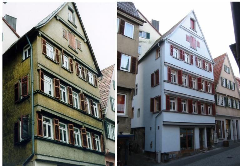
Abb. 7 Gelungene Synthese zwischen Wärmeschutz und Denkmalpflege in der Tübinger Altstadt, links vor der Sanierung, rechts danach (Fotos: Olaf Hildebrandt)
