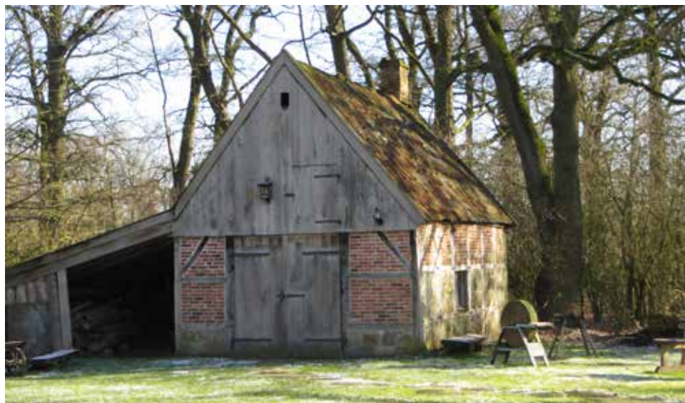
Backhaus am Heimathaus Hovesaat
