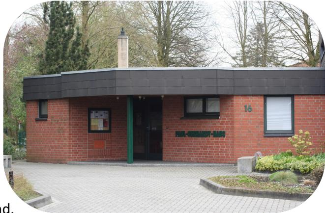
Die Außenwände bestehen aus Holzständerwerk und sind mit Mauerwerk verblendet. Die braunen Holzfenster stammen aus den Baujahren und sind mit Isolierglas versehen. Das Pultdach ruht auf Holzsparren und ist mit schwarzen Dachziegeln eingedeckt und mit einer ca. zwei cm dicken Wärmedämmschicht versehen.
