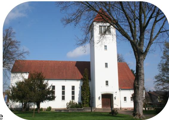
Der eingeschossige Anbau besteht aus Kalksandstein-Mauerwerk mit Wärmedämmverbundsystem und Kunststofffenstern mit Isolierverglasung. Holzsparren tragen ein Walmdach, das ebenfalls mit roten Dachziegeln gedeckt wurde.
