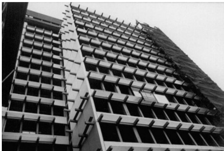
Das Kreishaus im Rohbau: fast fertig - aber noch ohne Glasfassade (Quelle: Kreisarchiv Siegen-Wittgenstein, Fotosammlung Pressestelle)
