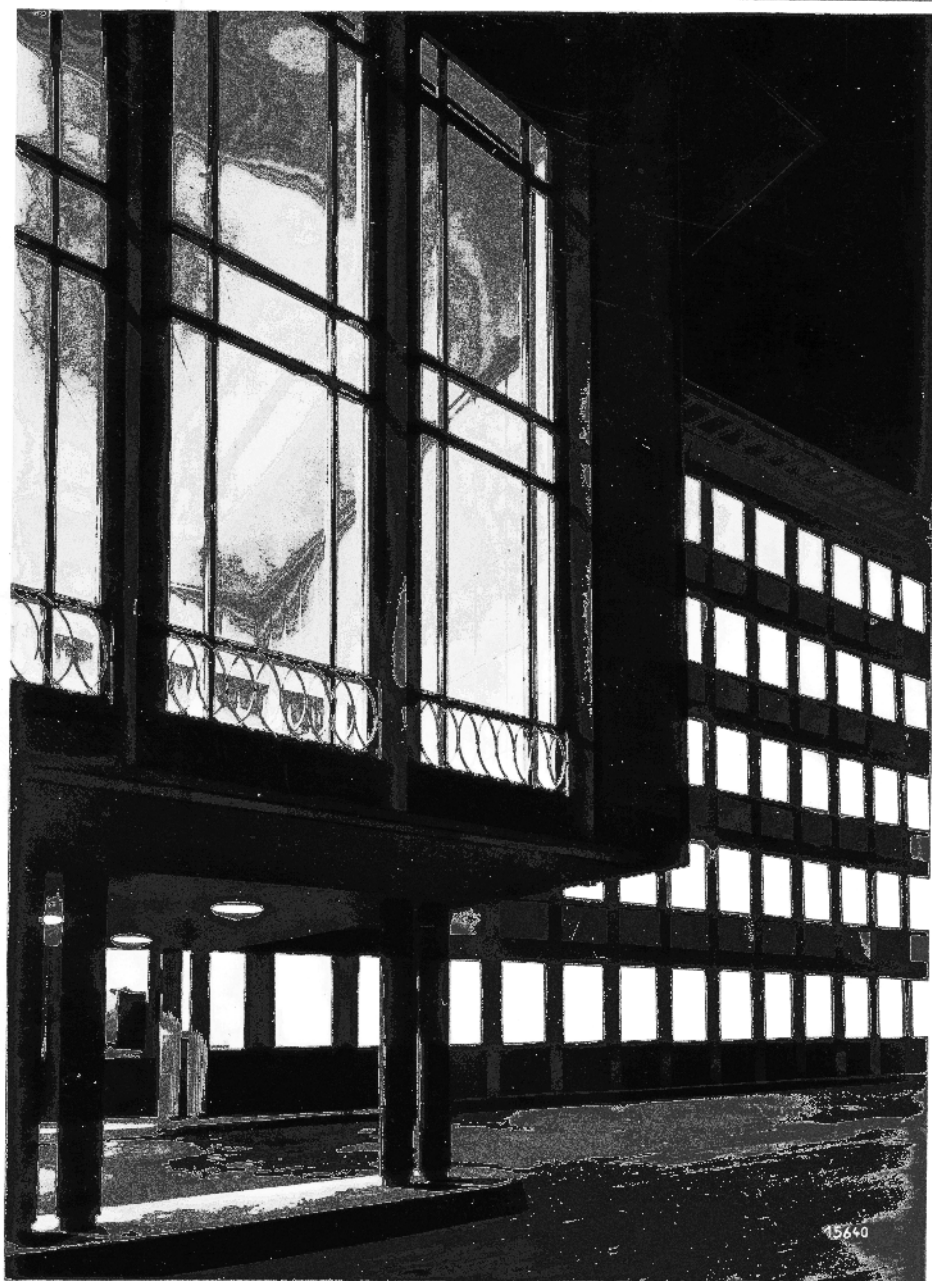
Kreishaus-Erweiterungsbau, 1955 (Quelle: Kreis Siegen-Wittgenstein, Fachservice Gebäude, Foto Besser, Siegen)
