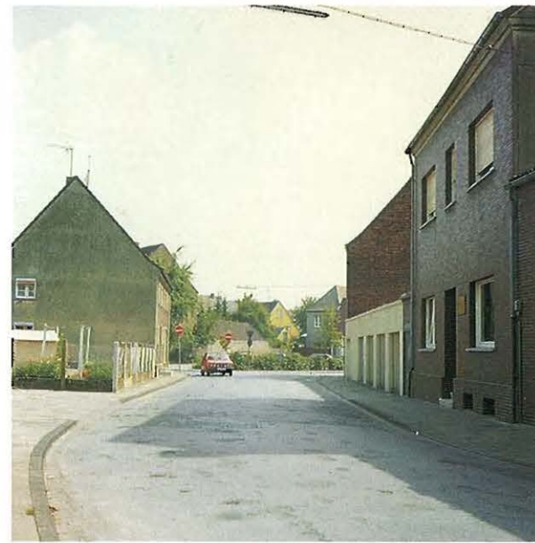
NORDWALL, Blick von der Hühlsstraße in Richtung Bergstraße
