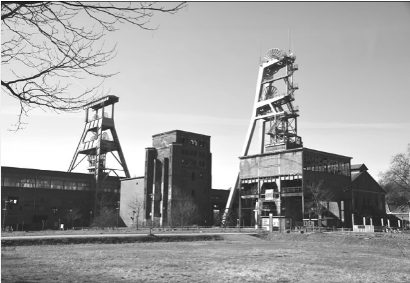
Gesamtansicht der Zeche Ewald
