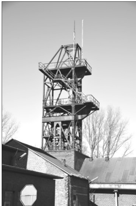
Fördergerüst General Blumenthal, Schacht 7
