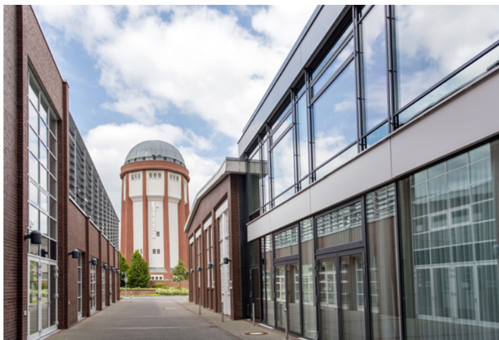
Der Wasserturm auf dem Gelände der Firma Miele wurde 1915 erbaut und stand bis 2013 im Eigentum der Deutschen Bahn, die ihn früher nutzte, um Dampflokomotiven mit Wasser aufzutanken. Er dient bis heute zur Bevorratung von Betriebswasser und als Wasser-Entnahmestelle für die Miele-Werkfeuerwehr. Foto: Miele
