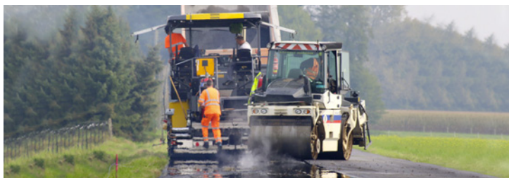
Asphaltarbeiten an der Kreisstraße 42 in Verl. Foto: J. Focken
