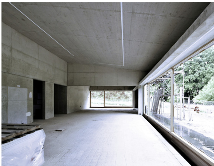
Blick vom Eingang durch das Foyer ins neue Museum Peter August Böckstiegel in Werther-Arrode.
