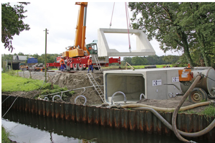
Brückenbau an der Bleichestraße in Verl. Foto: J. Focken
