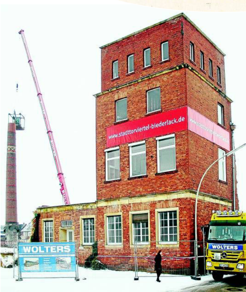
Am 1. Februar 2010 wurde der 40 Meter hohe Schornstein Schicht für Schicht abgetragen, der Turm blieb erhalten. Foto: Dieter Schmitz
