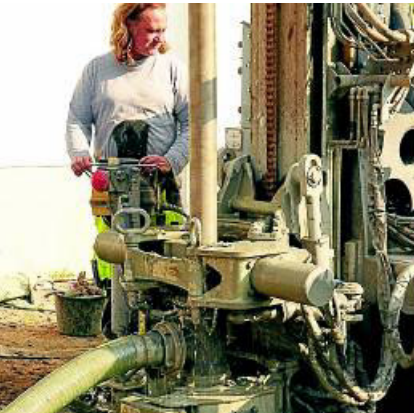
Bohrungen für die Installation der Erdwärmepumpe im September 2017 Foto: Dieter Schmitz
