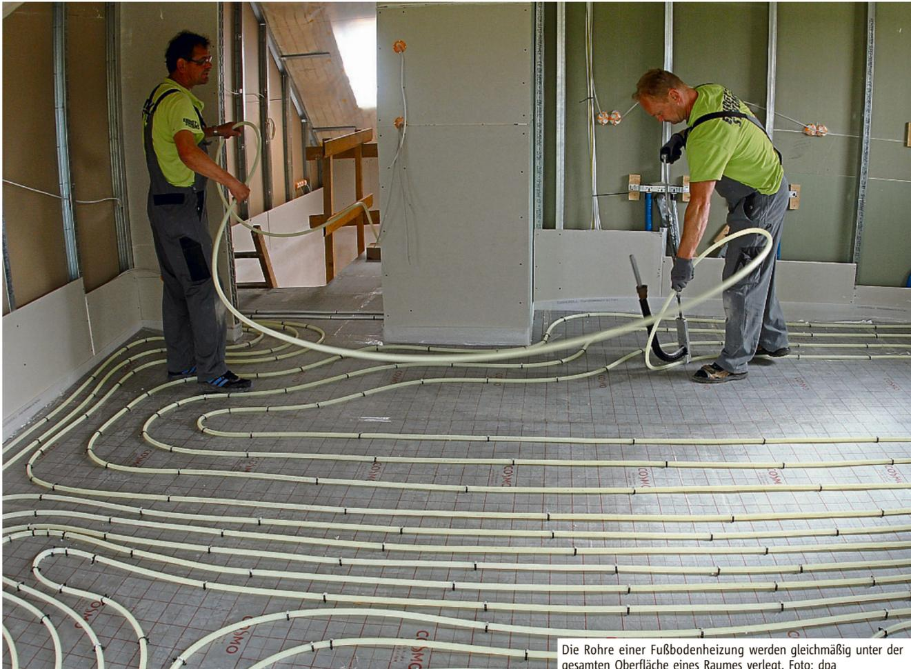
Die Rohre einer Fußbodenheizung werden gleichmäßig unter der gesamten Oberfläche eines Raumes verlegt. Foto: dpa
