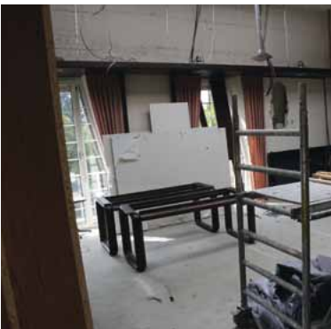
Umbauarbeiten in der Verwaltung
