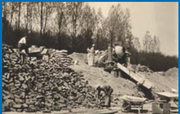
Bauarbeiten für das Mutterhaus beginnen
