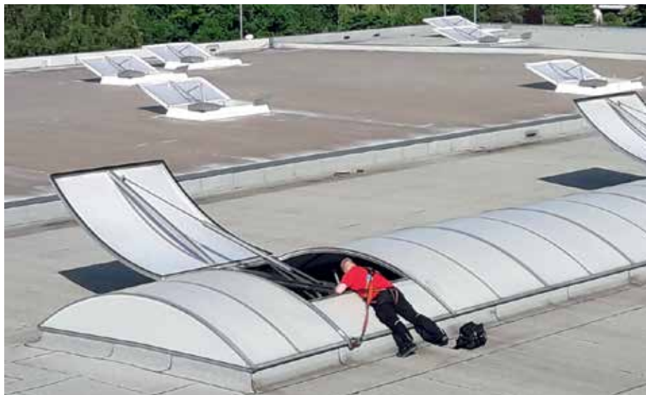
Wartung einer Rauchwärmeabzugsanlage
