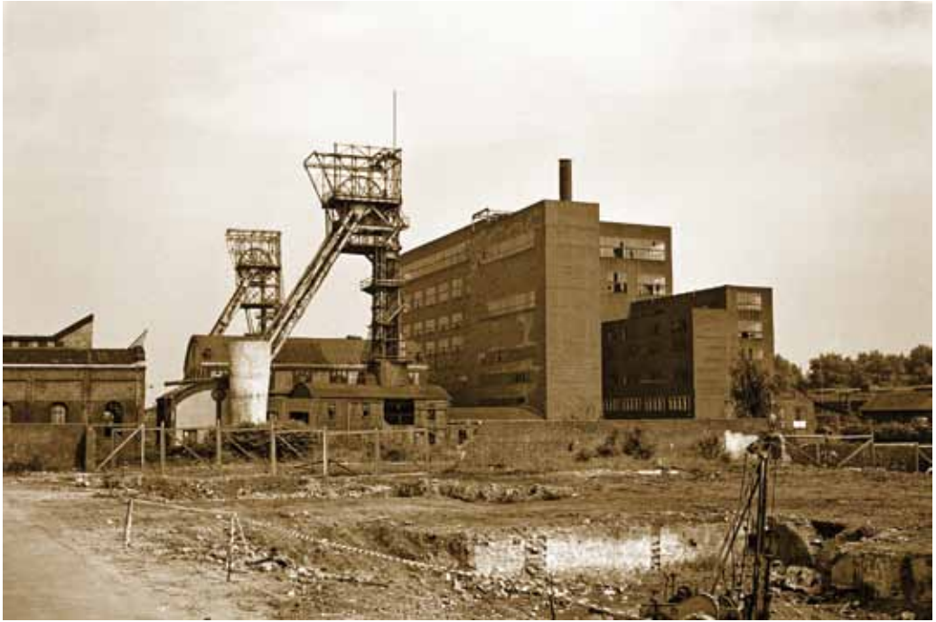
Zeche Lothringen 1979 - von der Turnstraße aus gesehen - vor dem Abriss der beiden Fördertürme und der Kohlenwäsche
