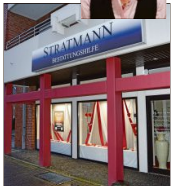
Das neue Institut an der Bahnhofstraße 2 mitten im Ortskern.
