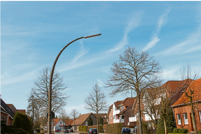
Auf einem Teilstück der Hauptstraße zwischen Engelstraße und Wischhausstraße wird die Straßenbeleuchtung erneuert.
