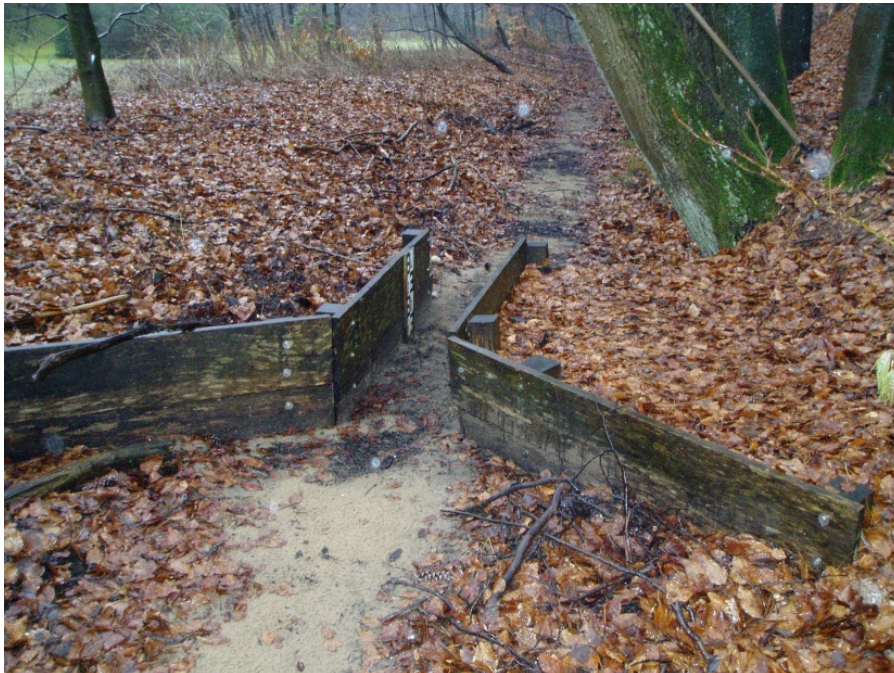
Bild 1 Trocken gefallender Pegel WW 01 am Sprungbach in Bielefeld-Sennestadt
