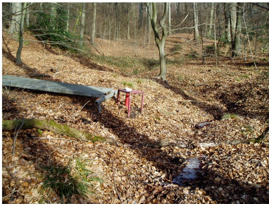
Bild 3: Grundwasser-Messstelle G 34 der Firma Christinen Brunnen in Bielefeld-Quelle
