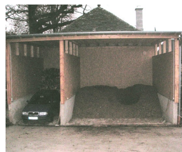
Hackschnitzel-Bunker und Geräte-Remise
