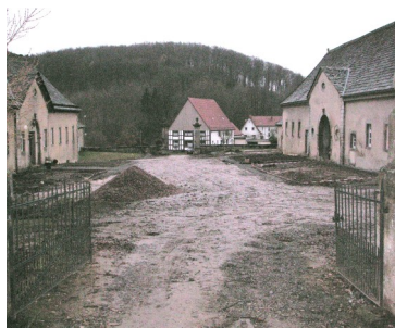
Der im aktuellen Ausbau befindliche Innenhof
