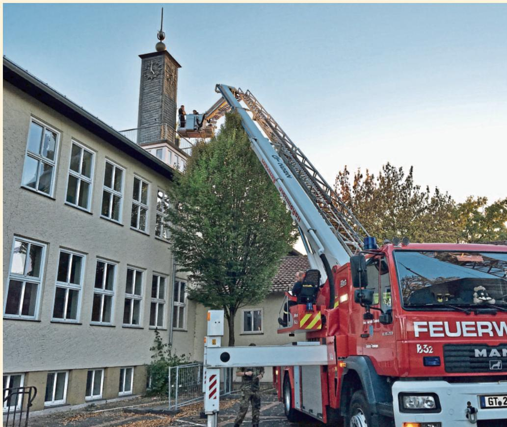
**Wieder intakt:** Mithilfe des Hubwagens der Feuerwehr erfolgte der Einbau der reparierten Turmuhr. Das Innenleben der Uhr war total verrostet.
