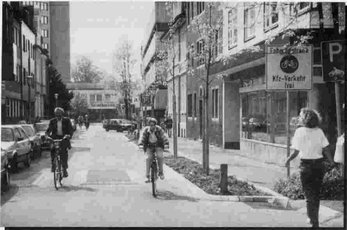
Abb. 3: Fahrradstraße, umgestaltet mit Pflasterkissen, Gladbeck
