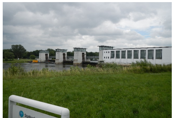
Zwei Bauwerke zu erheben: Bewegliches Wehr und Wasserkraftanlage
