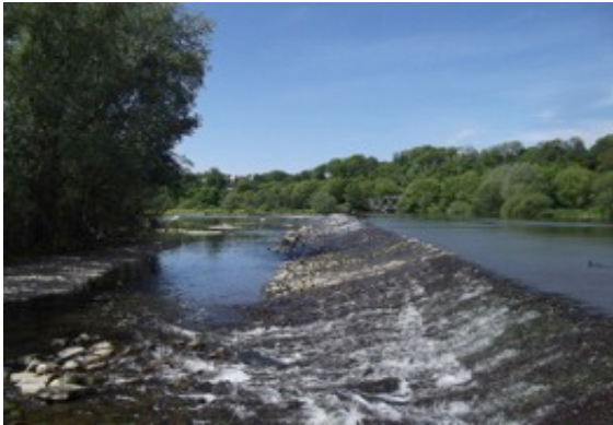
Winkel zur Gewässerachse < 45^\circ
