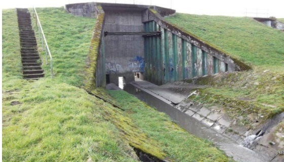
Einschnitt in Erdkörper eines HRB, nicht zu erheben
