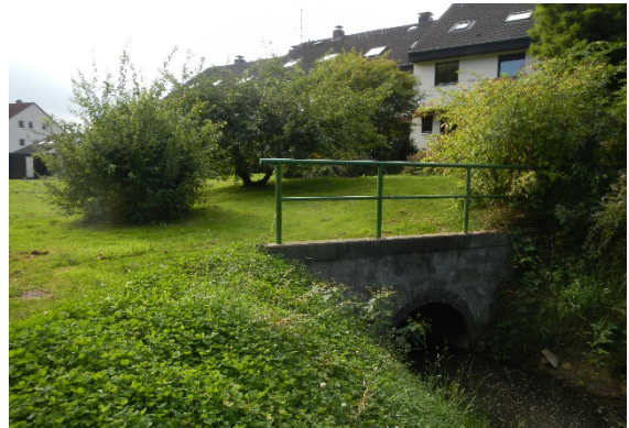
Sonstiges Bauwerk – Verrohrung
