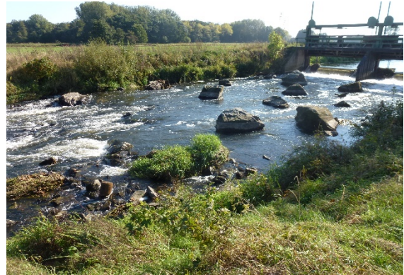
Zwei Bauwerke zu erheben: Bewegliches Wehr und Gleite
