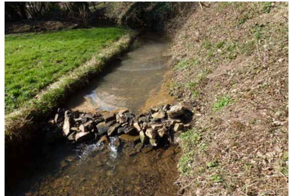
Wildes Bauwerk, Damm
