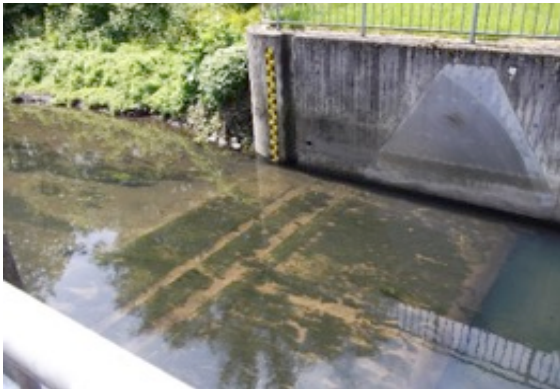
Verschlussstyp „Klappe“ (gelegt)
