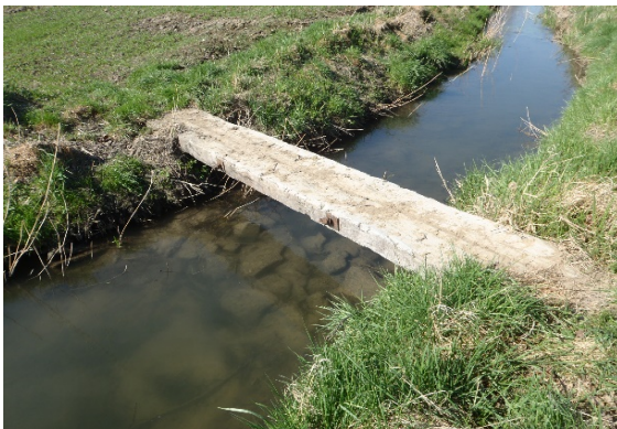
Keine Brücke, temporärer Steg
