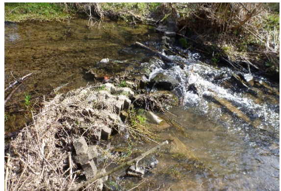
Wildes Bauwerk, Rampe
