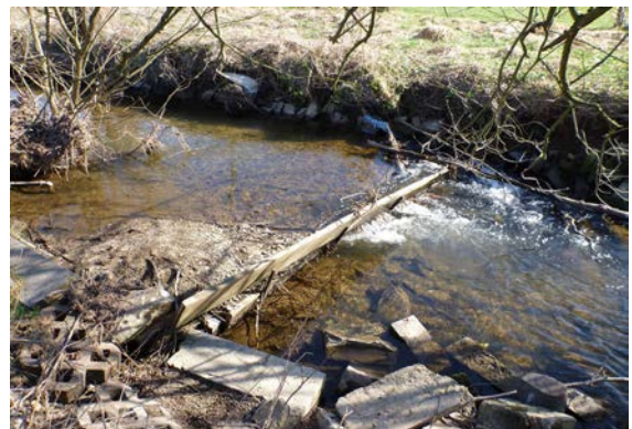
Wildes Bauwerk, Absturz
