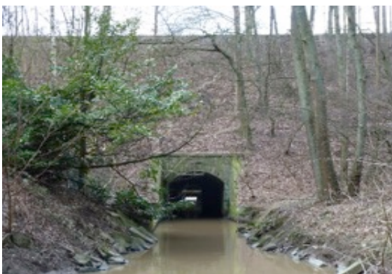
Kein Damm, sondern Verrohrung
