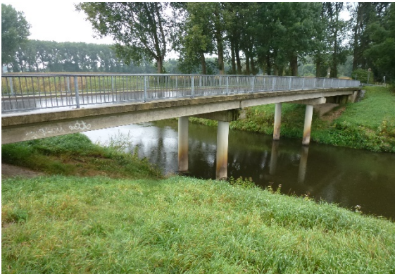
Sonstiges Bauwerk – Brücke
