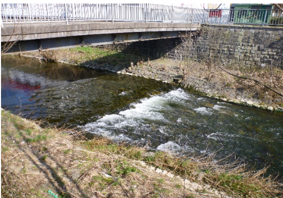
Zwei Bauwerke zu erheben: Brücke und Rampe
