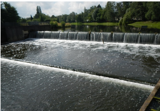
Drei Bauwerke zu erheben: Bewegliches Wehr, Gleite und Absturz
