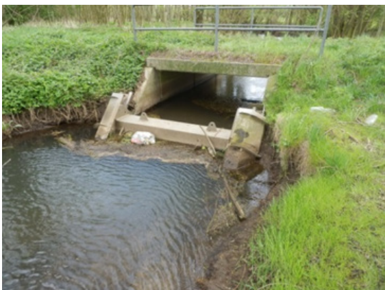
Technischer Einbau zum Rückhalt von Treibgut, nicht als Bauwerk zu erheben
