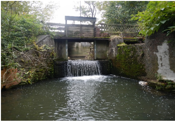
Verschlussstyp „Schütz“ (mit Sockel)
