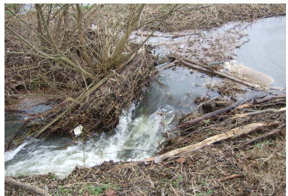
Kein Bauwerk, Totholzverkläuerung
