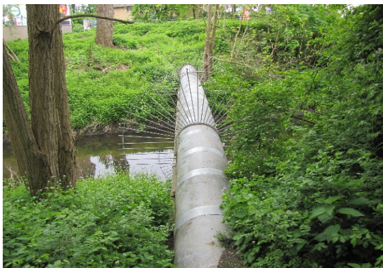
Rohrbrücke, nicht zu erheben als Brücke
