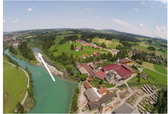
Ausleitung, nahezu 80 % des Wassers; Ausleitungsstrecke in Pfeilrichtung
