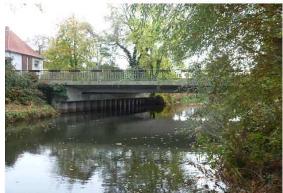
Brücke mit Widerlager
