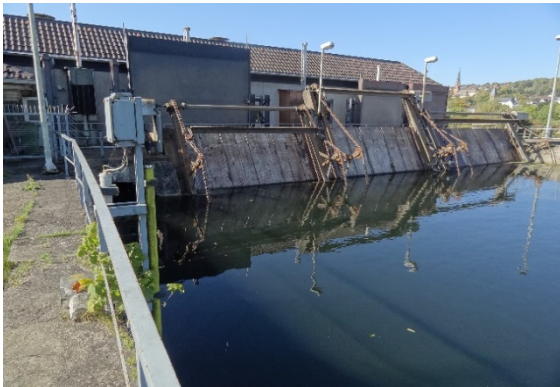
Wasserkraftanlage mit vorgeschalteter Rechenanlage
