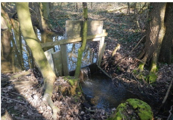
Verschlussstyp „Schütz“, zusätzlich Wildes Bauwerk
