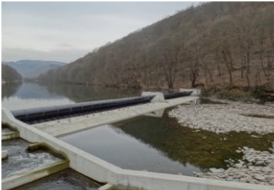
Verschlussstyp „Schlauch“ (mit Sockel)
