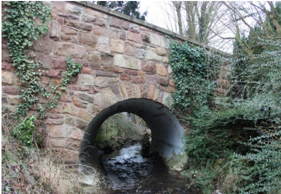
Durchlass, ohne Berme
