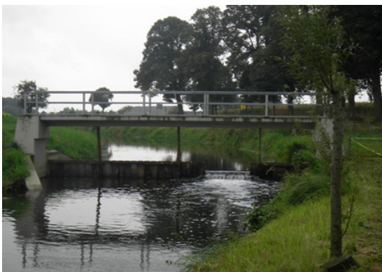
Nadel, teilweise entfernt
