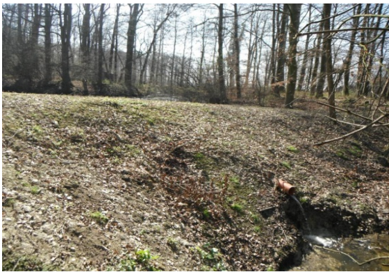
Damm, Wasserfläche hinter Bauwerk nicht erkennbar
