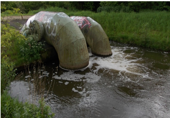
Sonstiges Bauwerk - Schöpfwerk/Pumpwerk
