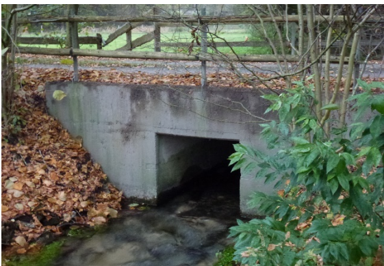
Sonstiges Bauwerk – Durchlass
