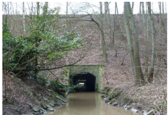
Sonstiges Bauwerk – Verrohrung im Erdkörper
