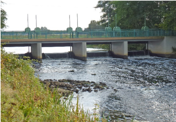
Zwei Bauwerke zu erheben: Bewegliches Wehr und Brücke
