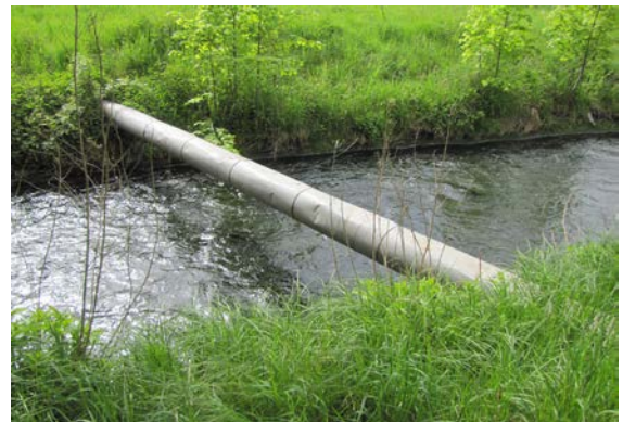
Keine Brücke, Rohrbrücke
