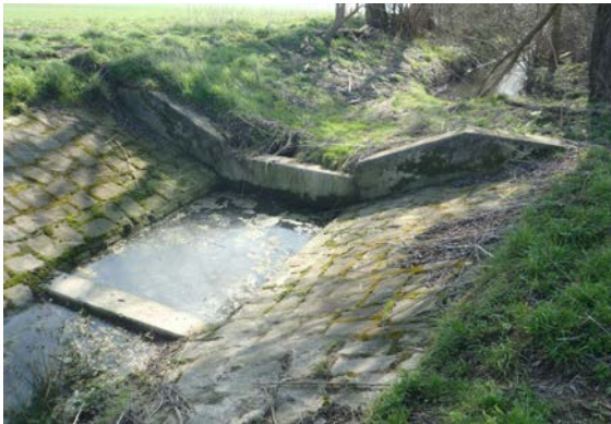
Winkel zur Gewässerachse \geq 45^\circ
