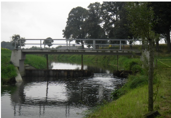
Verschlussstyp „Nadel“ (mit Sockel)
