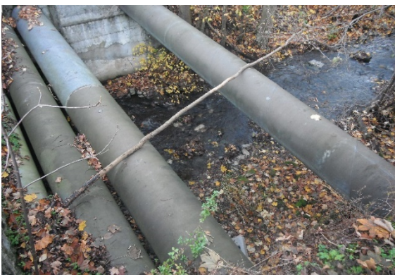
Kein Düker im Sinne dieses Verfahrens, Rohrbrücke
