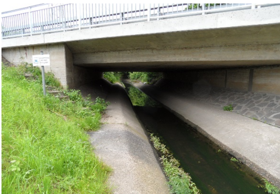
Berme befestigt, rechts und links
