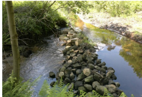
Winkel zur Gewässerachse < 45^\circ
