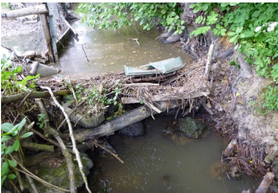
Wildes Bauwerk, Damm
