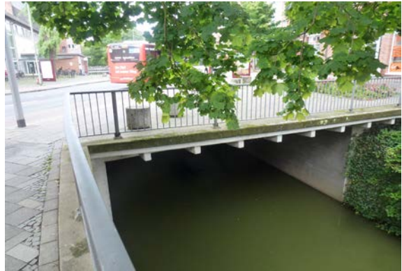
Berme nicht vorhanden
