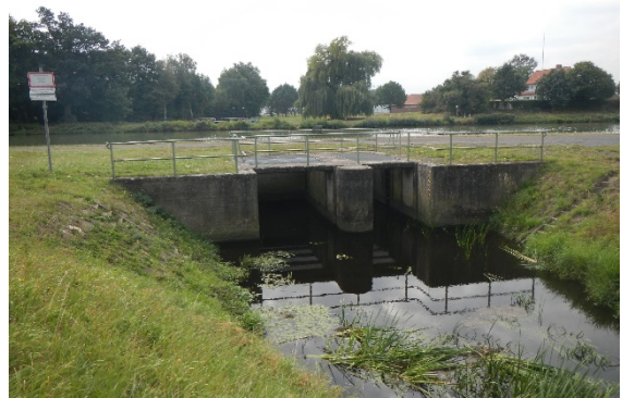
Sonstiges Bauwerk – Düker
