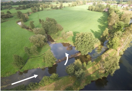
Ausleitung, Gewässerverlauf = Ausleitungsstrecke in Pfeilrichtung
