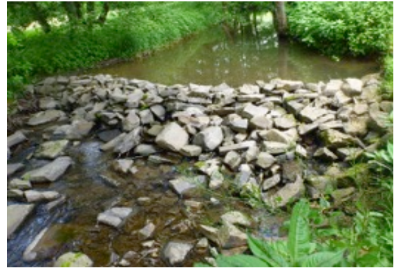
Damm aus Steinen geschüttet
