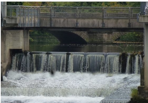
Querbauwerk – Bewegliches Wehr
