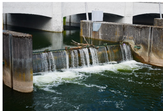
Verschlussstyp „Klappe“
