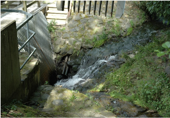
Einlauf in ein Pumpwerk
