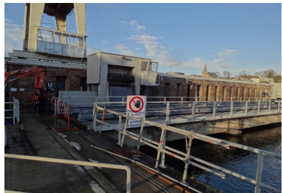
Wasserkraftanlage mit vorgeschalteter Rechenanlage
