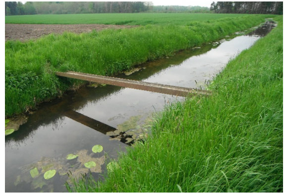
Temporärer Steg, nicht zu erheben als Brücke
