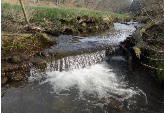
Gutes Foto: Bauwerk und Gewässer zu erkennen
