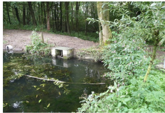
Damm, Ablaufbauwerk Mönch
