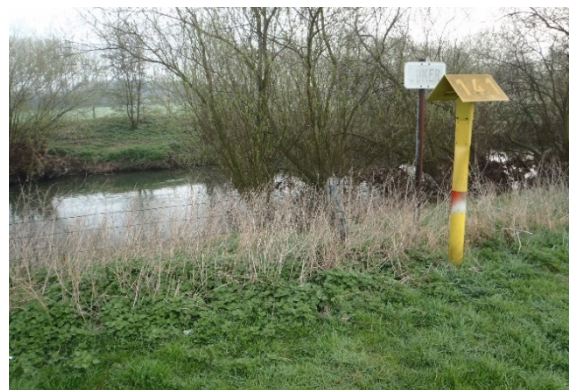
Kein Düker im Sinne dieses Verfahrens, Gasfernleitung
