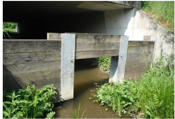
Querbauwerk – Bewegliches Wehr
