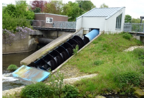
Wasserkraftanlage mit Wasserkraftschnecke
