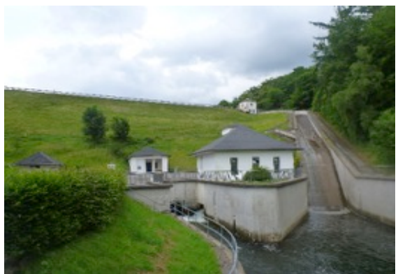
Kein Damm, Talsperre mit Hochwasserentlastung
