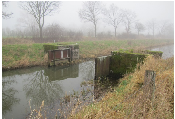
Sonstiges Bauwerk – Siel
