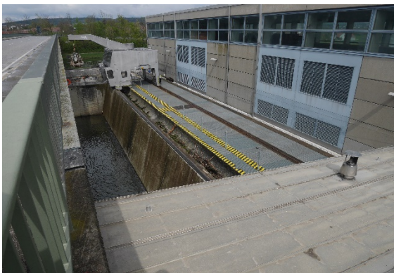
Wasserkraftanlage mit vorgeschalteter Rechenanlage
