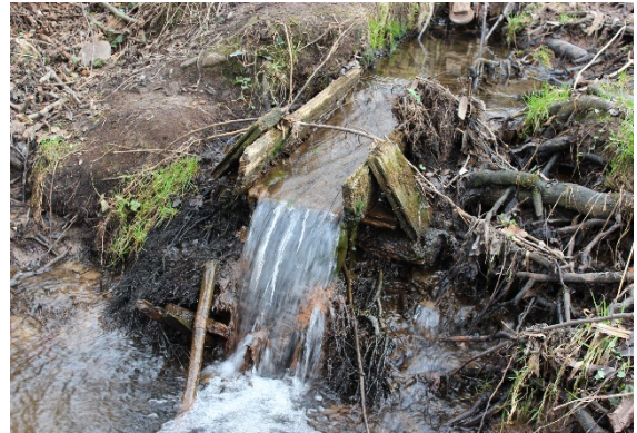
Wildes Bauwerk, Absturz
