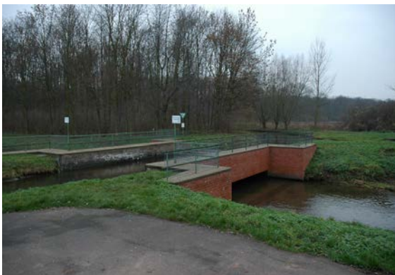
Brücke nur für das untere Fließgewässer
