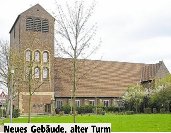
Neues Gebäude, alter Turm
