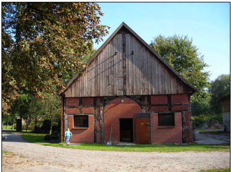
Längsdeelenfachwerkhaus, die Stalungen wurden erneuert, das Deelentor wurde z.t. zugemauert.
