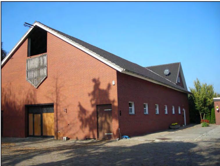
Die neuen Stallungen sind in Ziegelbauweise gebaut worden.
