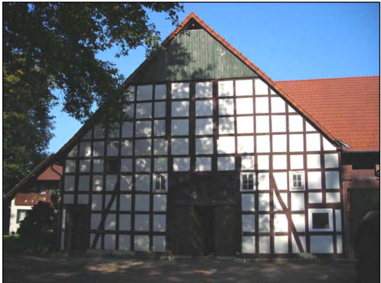
Längsdeelenfachwerkhaupthaus der landwirtschaftlichen Hofanlage mit T-förmigem Anbau.
