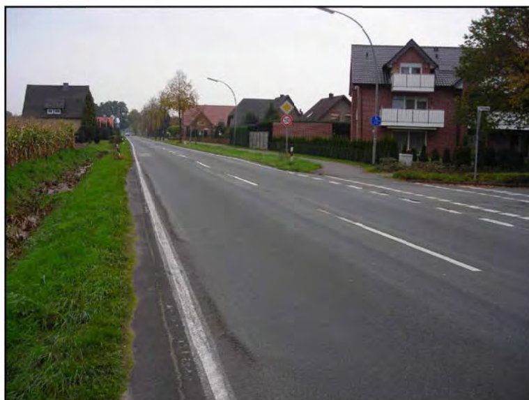
Holter Straße, Blick in Richtung Ortsausgang im Bereich des Peitzweges. Hier soll der Anschluss zum Gewerbegebiet erfolgen.
