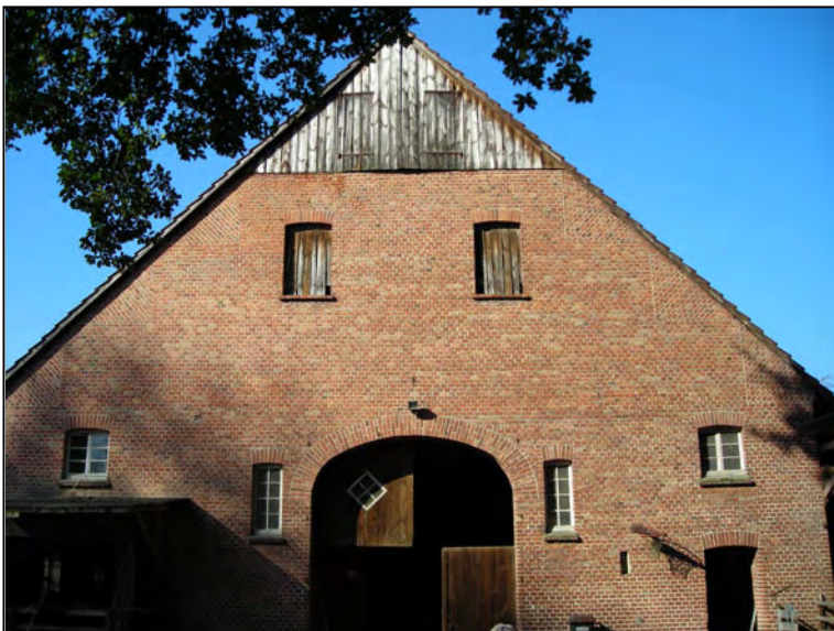
Längsdeelenhaus mit Ziegelmauerwerk
