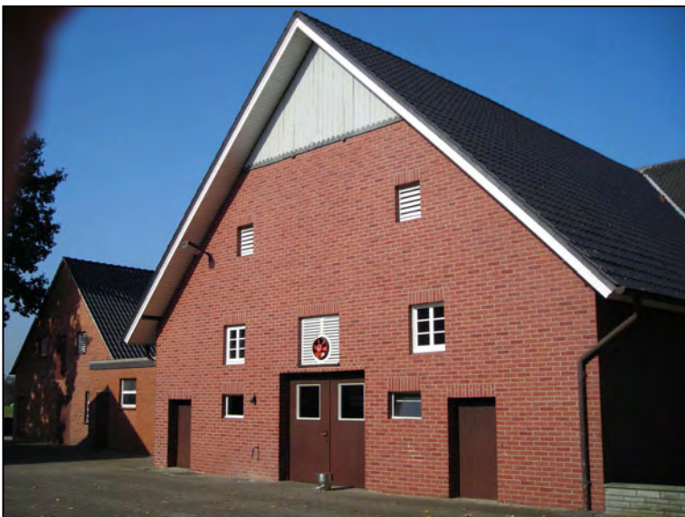
Längsdeelenhauptaus des landwirtschaftlichen Betriebes, das in Ziegelbauweise erneuert wurde.
