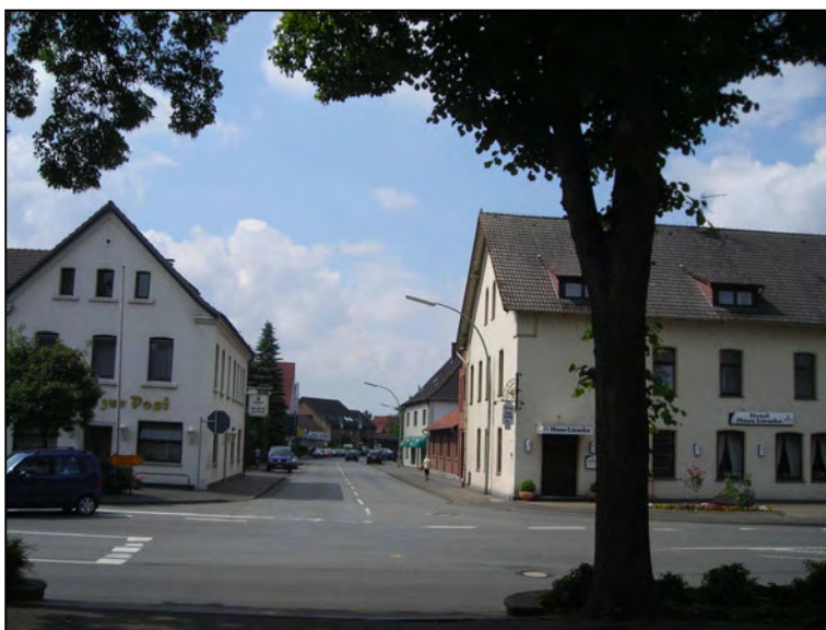
Zweigeschossige Putzbauten in Massivbauweise in der Paderborner Straße gegenüber der Kirche.
