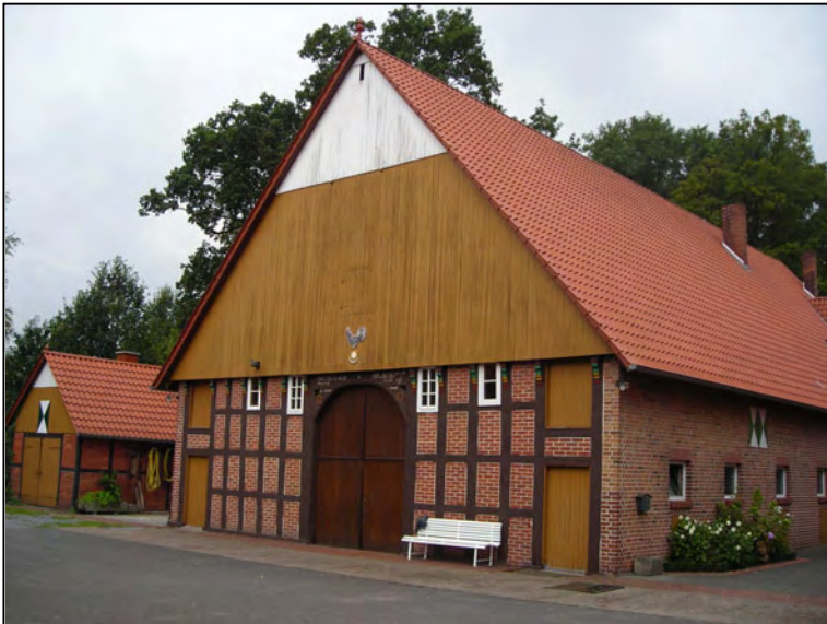
Fachwerklängsdeelenhaus mit gemauerten Gefachen, Giebelverbreiterung, roter Dacheindeckung, Deelentor und Sprossenfenstern.
