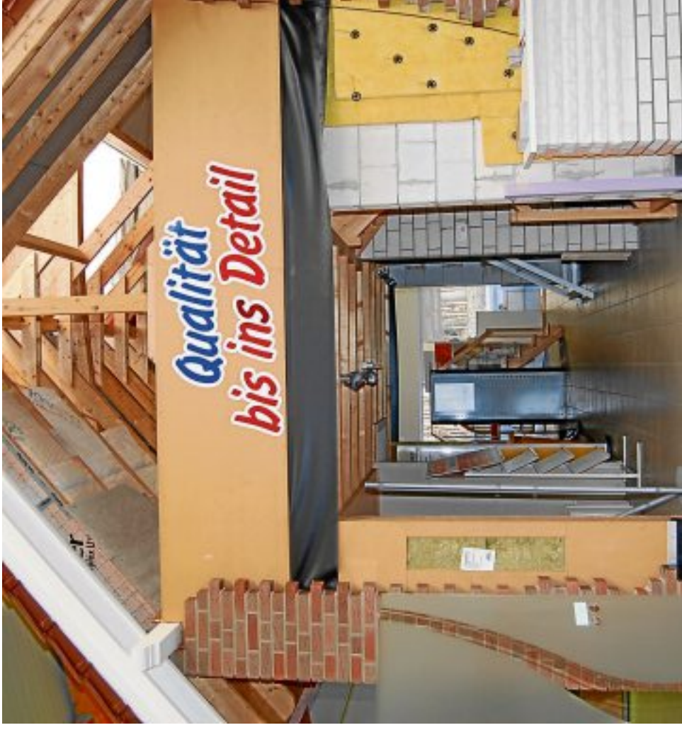
Interessant auch das „aufgeschnittene“ Musterhaus. Im Maßstab 1:1 werden hier Wandaufbau und Bautechnik den Kunden am Modell gezeigt.
