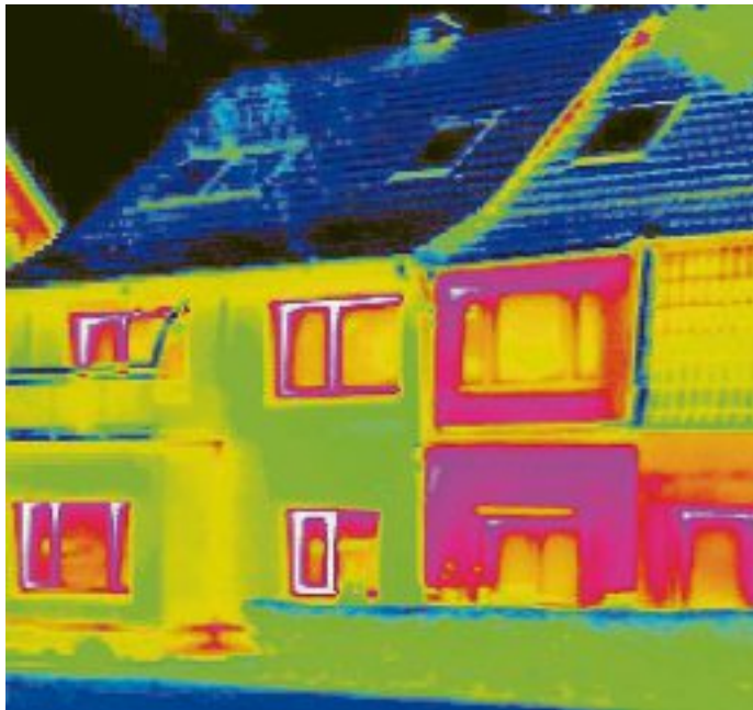
Wo geht Energie verloren? Die Thermografie-Aktion zeigt auf, wo am Haus Wärme entweicht.
