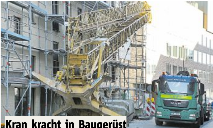
Kran kracht in Baugerüst
