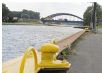
Verkehrsgünstig: Autobahn und Kanal begrenzen das Areal.
