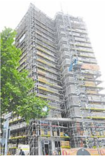
Noch nicht abgeschlossen sind die Arbeiten am Berliner Platz.
